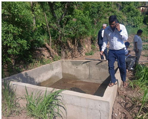
पक्की सिचाई पोखरी/ट्याङ्की निर्माण
