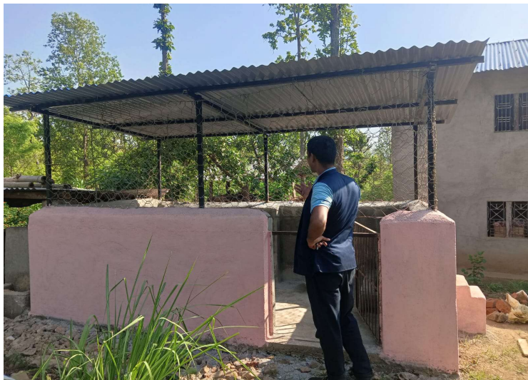
नयाँ बंगुरको खोर निर्माण
